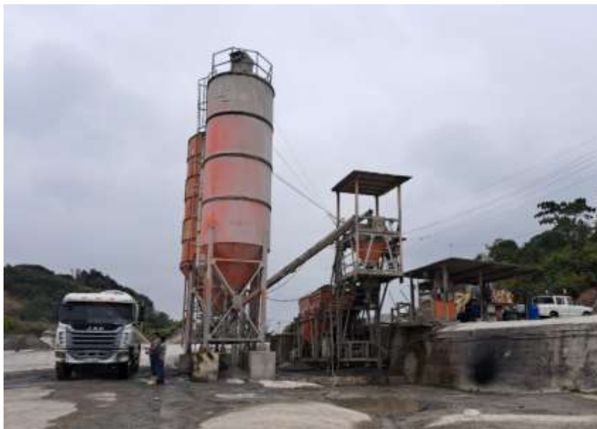
Foto 38. Planta de hormigón
