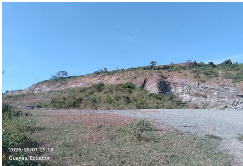
Figura 5.2-4. Frente de explotación del área minera Abrecabuya 3.
