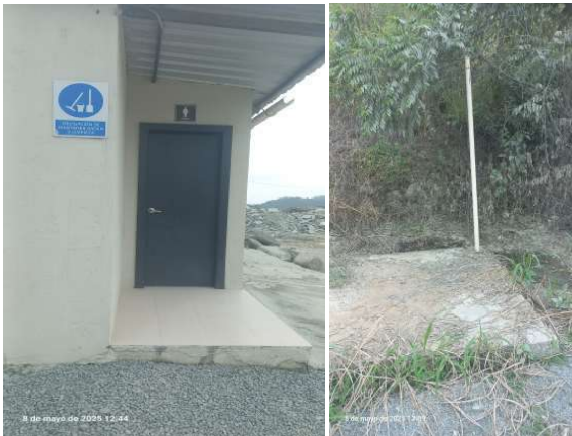
Foto 17. Baños y ubicación de poso séptico
