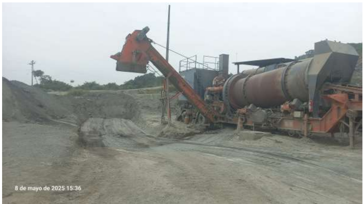
Foto 30. Planta de Asfalto
