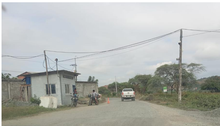
Figura 2.4-3. Garita de Control de ingreso y salida de vehículos.
