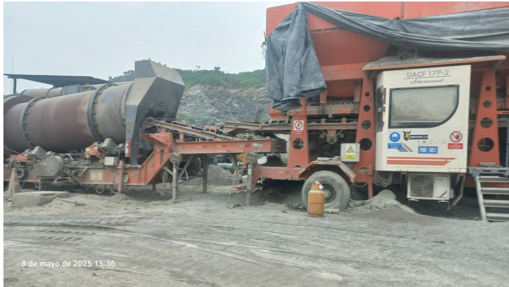
Figura 2.5-3. Planta de Asfalto (624550;9778149)
