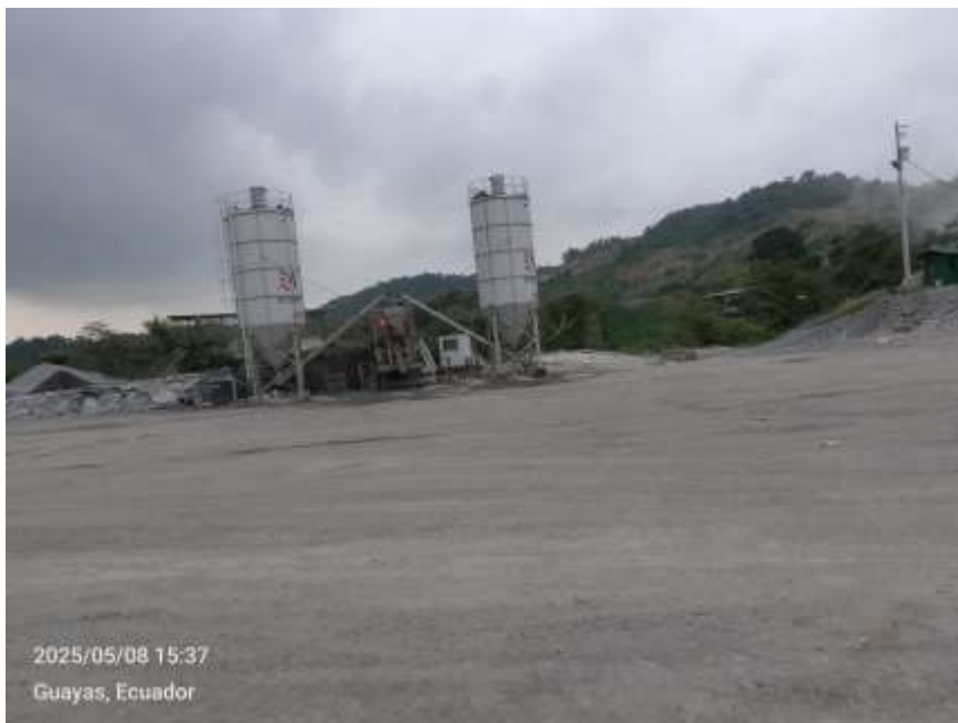
Foto 23.Planta de Hormigón Silo 1, y Silo 2
