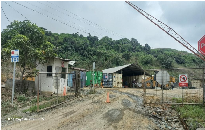
Figura 2.6-2. Garita de ingreso a frentes de explotación y plantas de trituración y hormigón.
