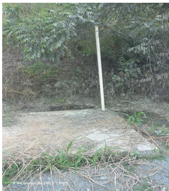
Figura 2.5-6. Pozo séptico (624595;9777882, WGS84, ZONA 17S)
