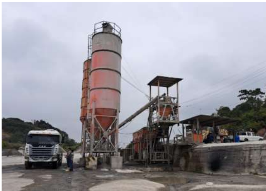
Foto 38. Planta de hormigón
