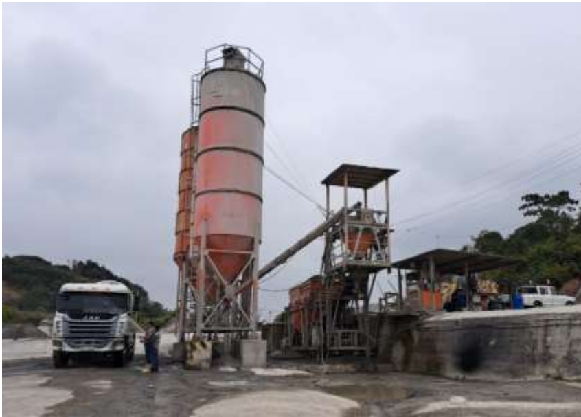
Foto 38. Planta de hormigón
