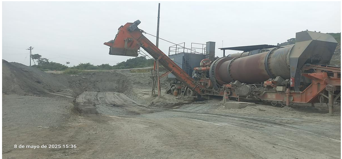
Figura 2.5-4. Tambor vibratorio de Planta de asfalto (624550;9778149)
