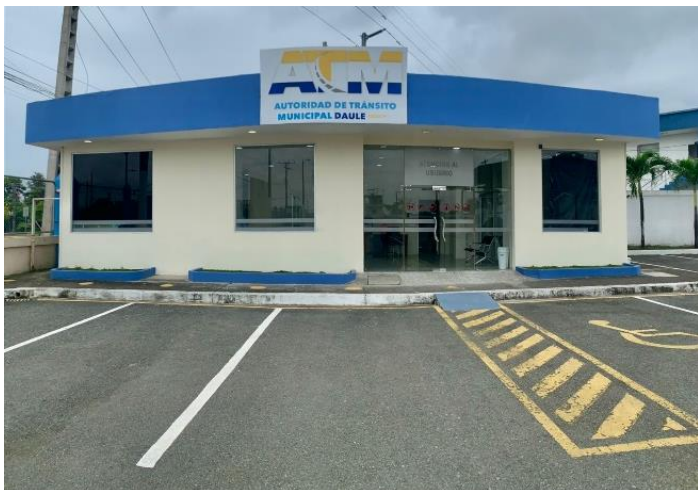
Imagen 1. Letrero y pintura de fachada de las oficinas de ATM Daule.
